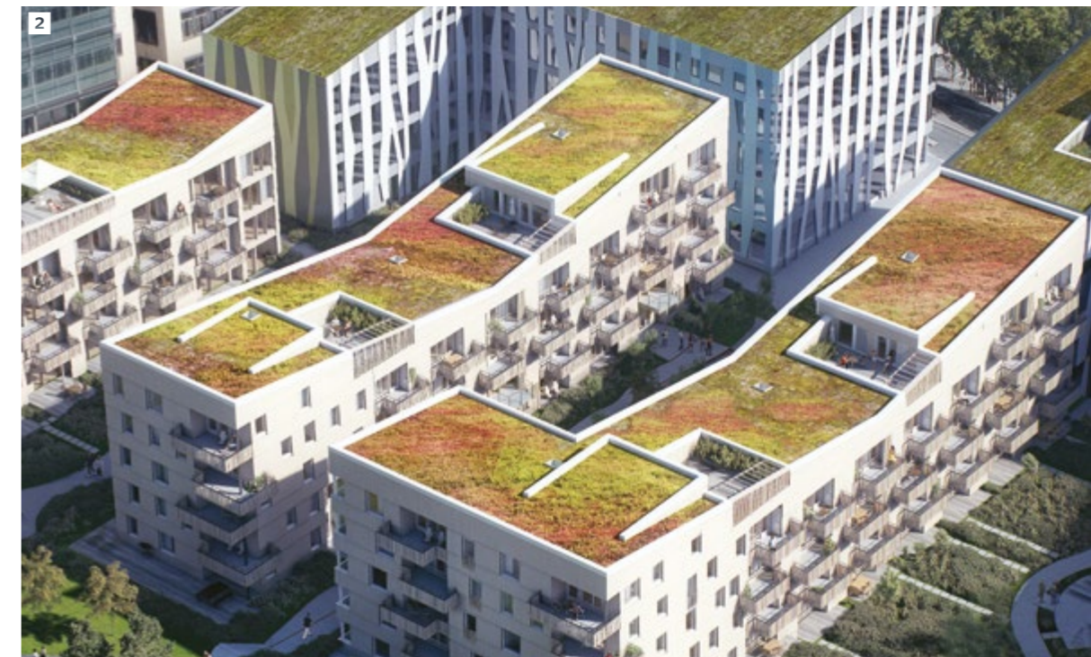
1. HBA Arkitekter AS, Playwood: modulbasert hytte. 2. April Arkitekter, Spikerverket boliger, Oslo (Illustrasjon: MIR).
