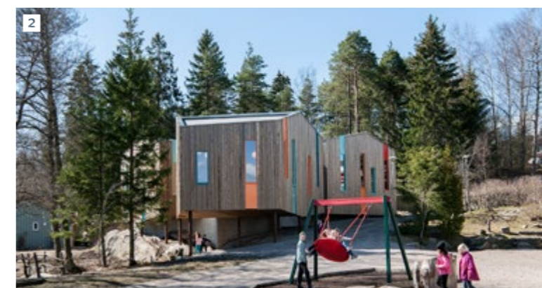
1. Superunion Architects AS i samarbeid med Space Group As, Ruten Sandnes. 2. LINK Arkitektur AS, Steinerskolen Greåker (Foto: Jiri Havran).
