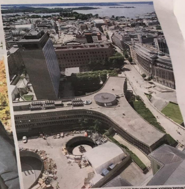
Planene for det nye Regjeringskvartalet er uten sidestykke i norsk arkitekturhistorie. Dette arbeidet mener arkitektene Statsbygg ber om høyere enn de gir. FOTO: TORE MEEK, NTB SCANPIX
